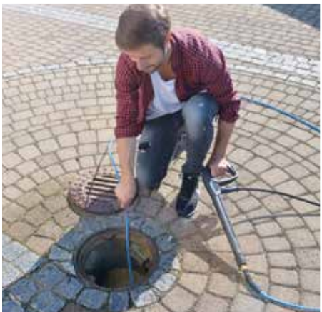
Abb. Rohrreinigungsschlauch
